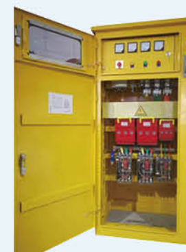
建筑工地用箱
